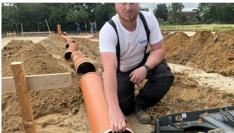
Robert Kohn verlegt gerade die Rohre für das Nahwärmenetz.
